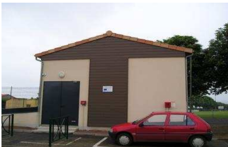
Fig. N°85 : Chaufferie de Mauzé-Thouarsais Source CCT
